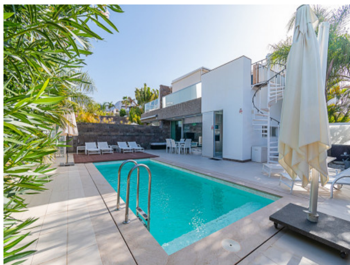
Ansicht der Fassade
