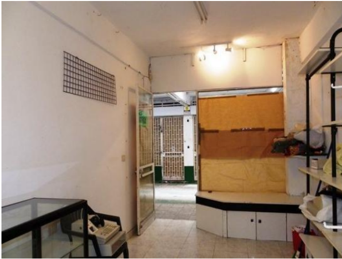
Stellfläche am zweiten Zugang
